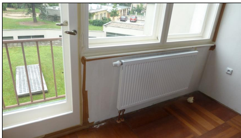
Obr. 6.3.8: 4. měření Blower Door testu - utěsnění funkční spáry vnějšího i vnitřního okna a přípojovací spáry
