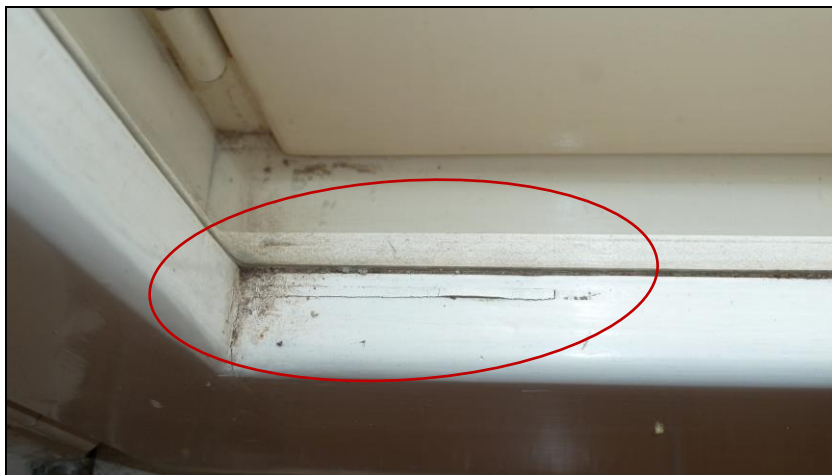
Obr. 6.2.8: Vnitřní dveře – degradace materiálu
