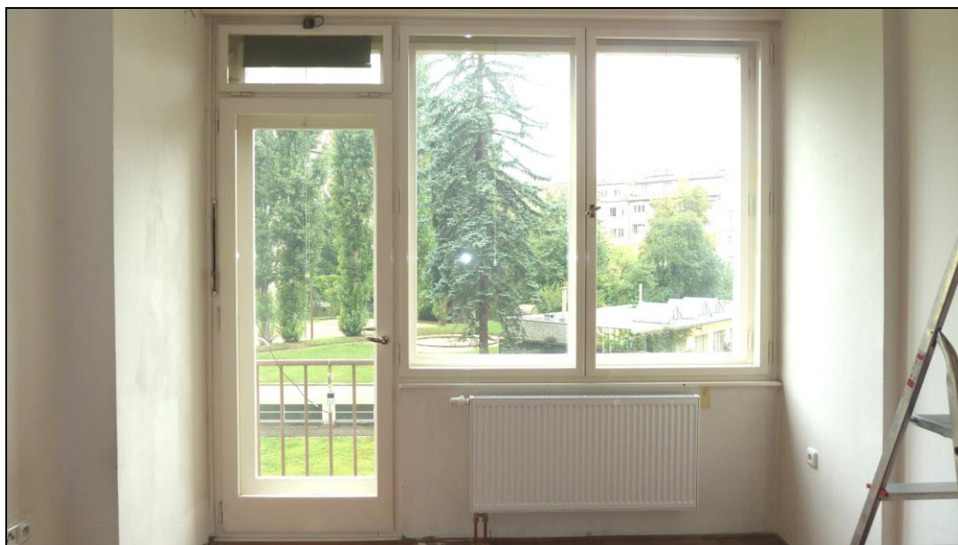
Obr. 6.1.3: Pohled na posuzované okno z interiéru
