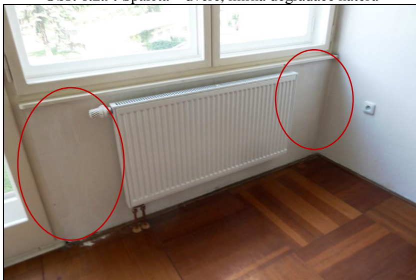
Obr. 6.2.10: Vlhkostní stopy v interiéru
