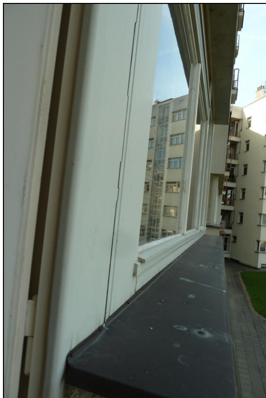
Obr. 6.2.3: Pohled z exteriéru, návaznost kuchyňského okna a okna do pokoje
