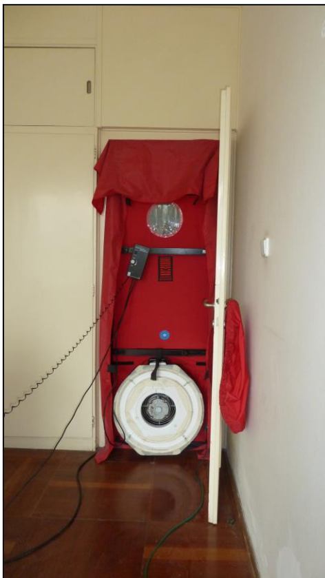
Obr. 6.3.2: Zařízení pro Blower Door test – utěsnění dvěří
