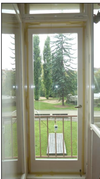
Obr. 6.3.5: 2. měření Blower Door testu – utěsněné funkční spáry vnějšího okna
