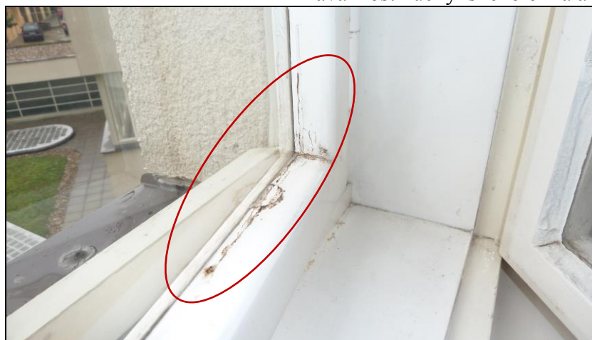
Obr. 6.2.4: Vnější okno - degradace materiálu (nátěr+dřevo)
