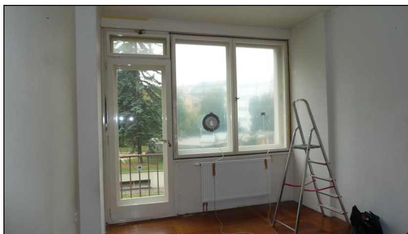
Obr. 6.3.9: Test vzduchotěsnosti okna prováděný pomocí clony
