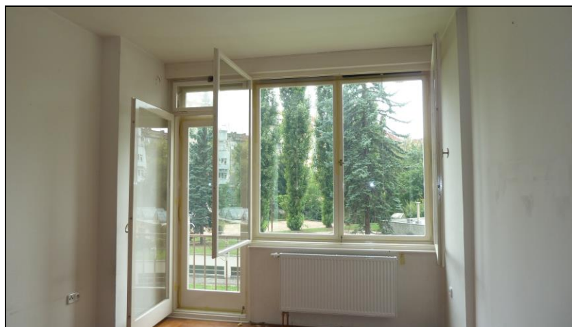
Obr. 6.3.4: 2. měření Blower door testu – utěsněné funkční spáry vnějšího okna
