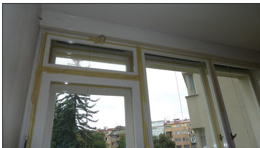
Obr. 6.3.6: 3. měření Blower Door testu – utěsněné funkční spáry vnějšího a vnitřního okna
