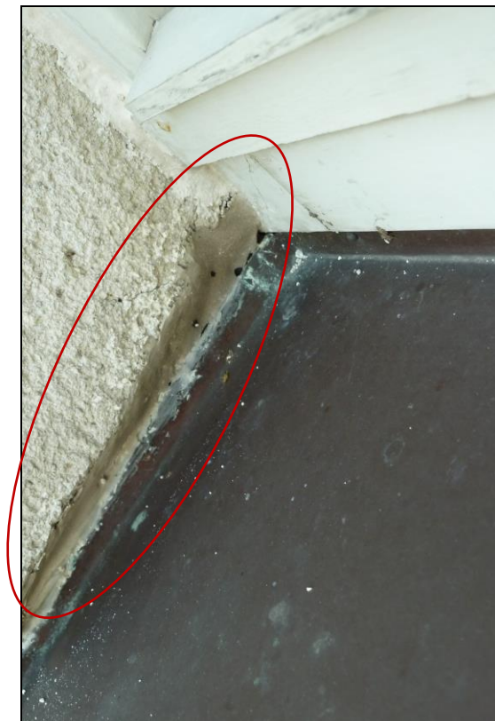
Obr. 6.2.11: Návaznost oplechování venkovního okenního parapetu na ostění, porušení těsnění (pružný tmel)
