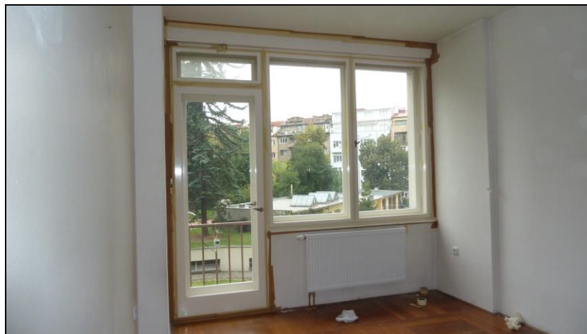
Obr. 6.3.7: 4. měření Blower Door testu - utěsnění funkční spáry vnějšího i vnitřního okna a přípojovací spáry
